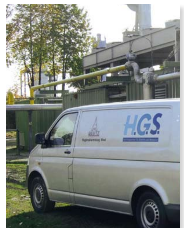
HGS – Service mit maximaler Kompetenz für Gasmotoren und Blockheizkraftwerke
